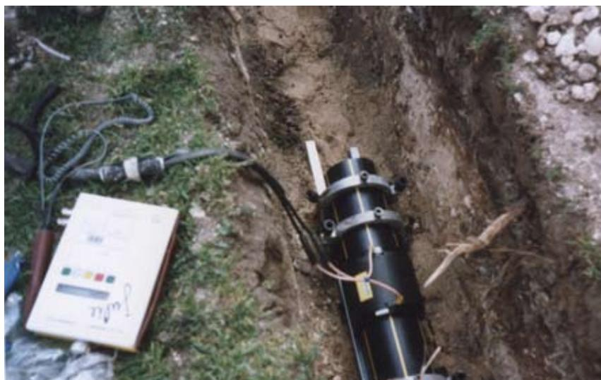
Рис. 1. Позиционер для фиксации соединения при сварке муфт.
