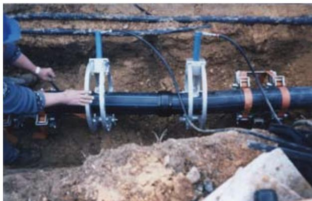
Рис. 10. Модель Posiplast 125 — фиксация труб с помощью гидравлических цилиндров.
