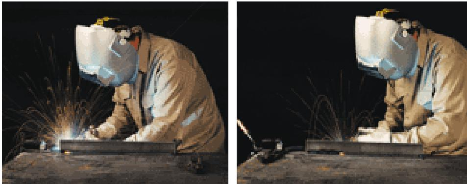
**Рис. 6 – Выполнение горизонтального углового шва при скорости подачи 4,4 м/мин.
