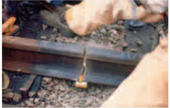
Рис.13 Сварка корневого шва
