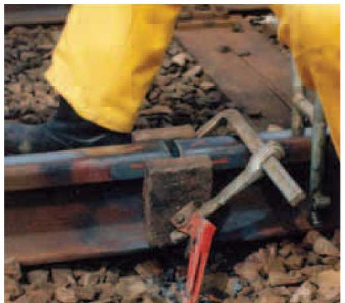
Рис.15 Зафиксированные медные башмаки перед сваркой шейки рельса
