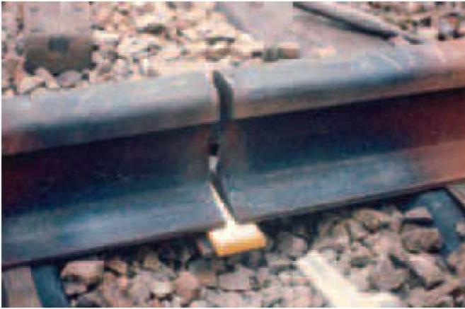
Рис.12 Установка подкладки
