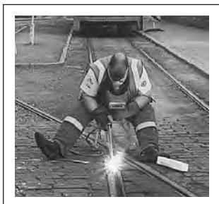
Ремонт трамвайных линий электродами OK 67.52
