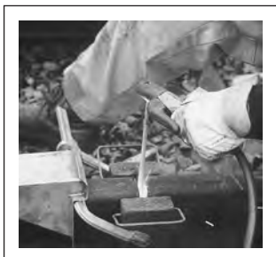
Сварка стыков рельсов электродами OK 74.78
