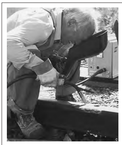
Наплавка головки рельса проволокой OK Tubrodur 15.43
